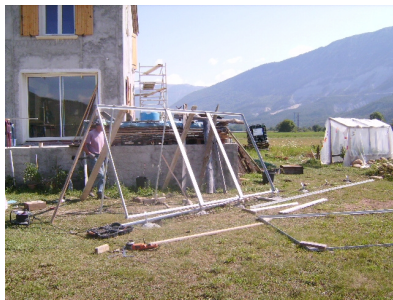
La cornière : les capteurs sont posés sur des entre-toises en caoutchouc pour que l'alu ne soit jamais en contact direct avec l'acier (couple galvanique)
